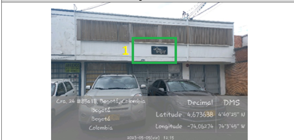
En la cual se evidencia la fachada del establecimiento comercial denominado LA VIE ROSE, en la que se observa: un (1) elemento publicitario tipo aviso en fachada identificado con el número 1, el cual al momento de la visita técnica se encontraba instalado sin contar con el registro ante la SDA
